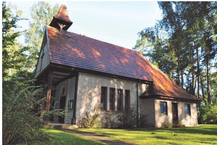
Fot.2. Obecny wygląd kaplicy w Sanatorium
