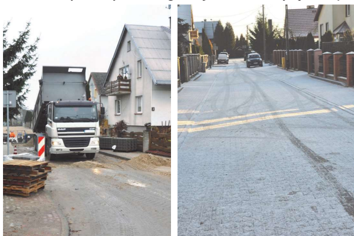
Ulica Wiśniowa podczas prac i tuż po ich zakończeniu.
