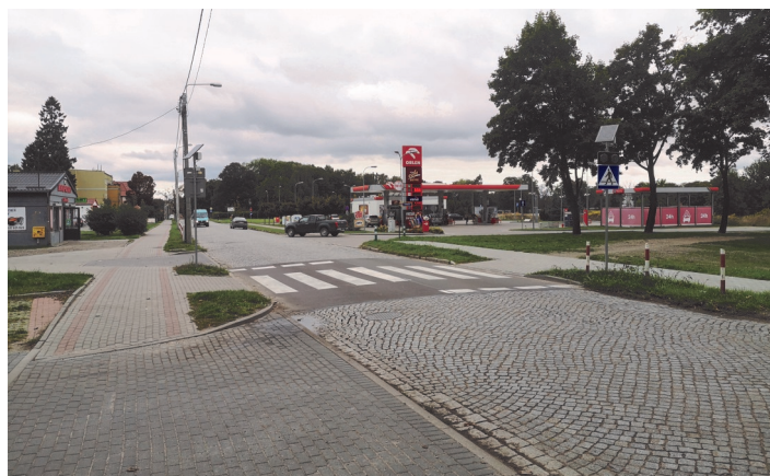
Wreszcie widoczne przejście dla pieszych przy Jagielly
