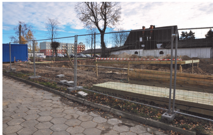
Plac budowy 12-lokalowego budynku TBS przy ul. Obrońców Westerplatte. Projekt zakłada metraż mieszkań w granicach około 40-50 m.kw., czyli typowych „przejściówek” na wynajem. Inwestycję realizuje kwidzyńska firma RODŁO.
