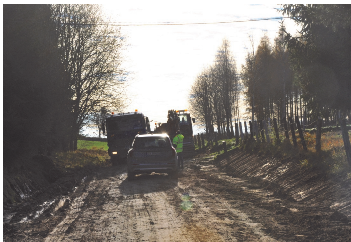
Budowa drogi z Sypanicy w kierunku Kałdowa
