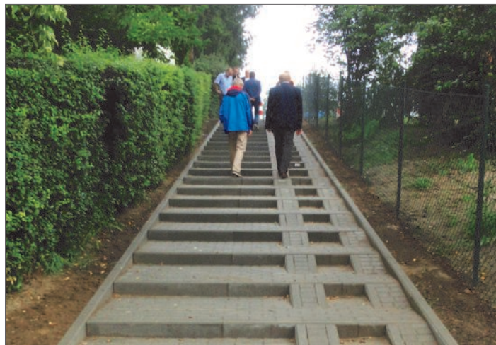
Schody pomiędzy ul. Pustą i Kasztanową, element inwestycji ul. Pustej. Cała inwestycja, bez projektu i nadzoru - 1.587 tys. zł.
